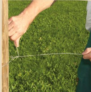
2. Loses Drahtende 3-mal um den Zugdraht wickeln
