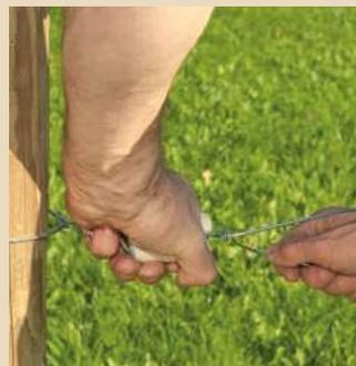
7. Loses Drahtende 5-mal um den Zaundraht wickeln
