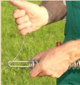
1. Draht in einen Bügel der Feder einführen
