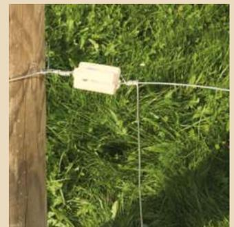
8. Drahtende lang lassen zur Querverbindung
