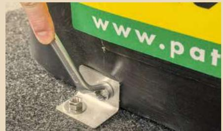
Montage auf einem überstehenden Betonsockel mit Haltewinkel
