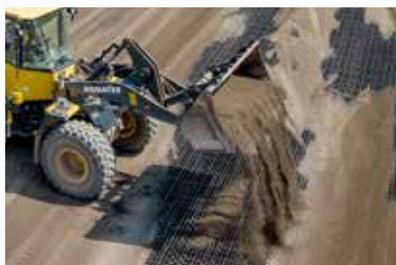
Verteilen des Füllmaterials mit einem Radlader. Hier wird Lavamaterial zur besseren Wasserspeicherung verwendet.
