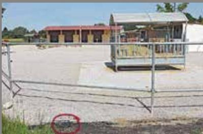
Auslauf eines Offenstalls, befestigt mit Progrid. Hier wurde das Gitter mit Kies überdeckt.
