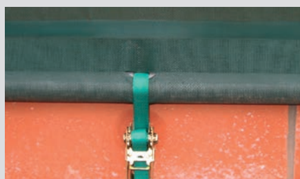
Hohlraum mit Stahlrohr und Ratsche
