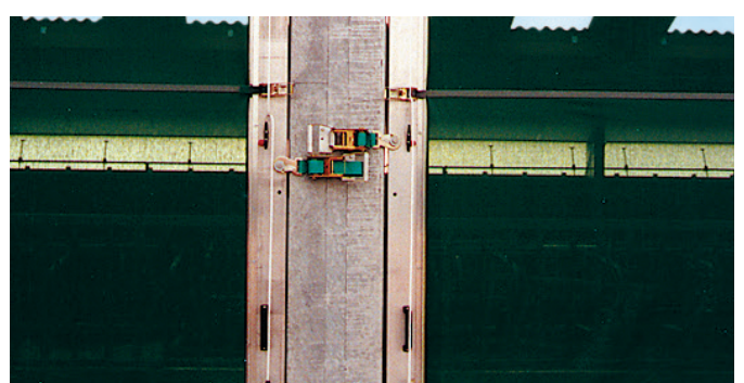
Ratschen sorgen auch bei starkem Wind für feste Spannung
