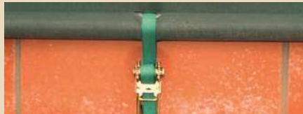
Hohlraum mit Stahlrohr und Ratsche
