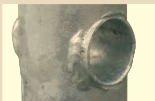
Hülse für stabile Aufhängung der Augenschrauben
