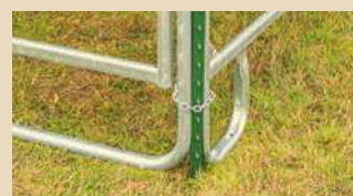
T-Pfosten als Sturmsicherung
