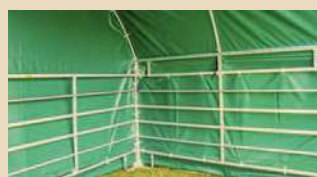
Giebelseite und Seitenwand aus Plane
