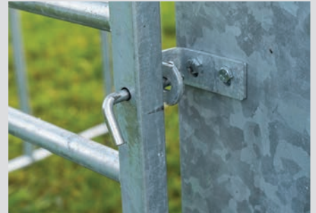
Sicherung des Kälberschlupfes durch zwei Bolzen
