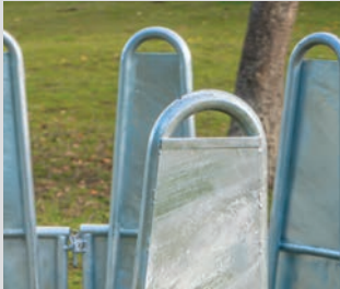
Blechverkleidete Palisadenbögen ohne scharfe Kanten
