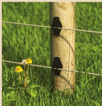
leichter Bewuchs – ab und zu berührt Bewuchs den Zaundraht
