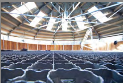
Progrid in einer Longierhalle mit Deckenführanlage. Die Gitter werden im Außenbereich treppenartig rund verlegt.
