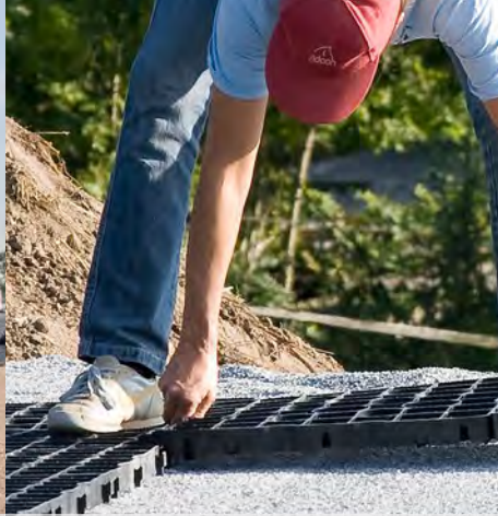
Verlegen der Lagen
