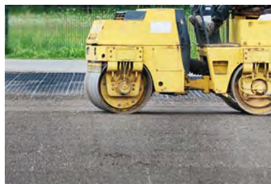
Bei Bedarf kann die Fläche auch nach dem Verfüllen der Progrid abgewalzt werden. Die Progrid sind für solche Belastungen gebaut.
