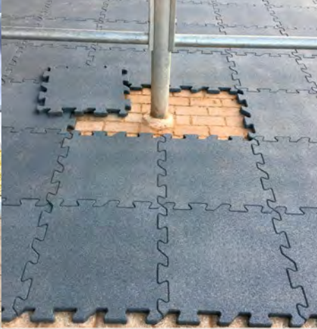
Sauber verlegt auf Pflaster
