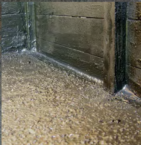
Auch dicht in den Ecken
