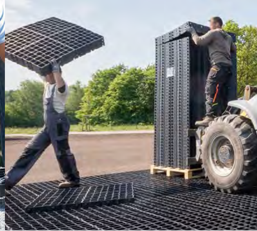
Verteilen der Progrid
