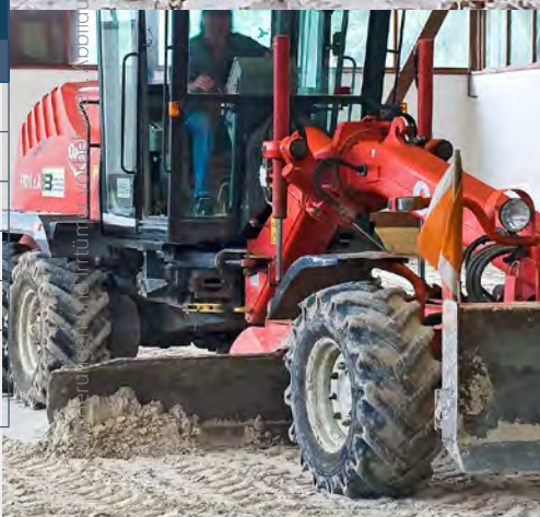
Verteilen der Tretschicht
