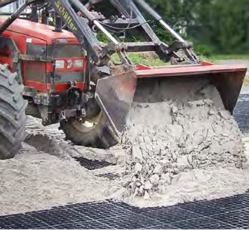
Verteilen des Sandes mit Traktor
