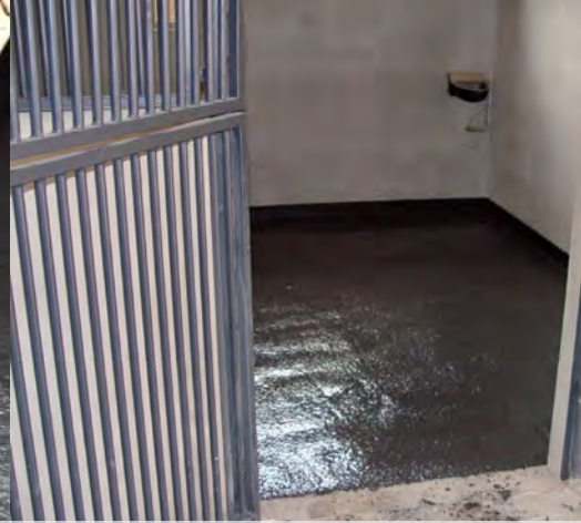
Fertige Box mit Flüssiggummi
