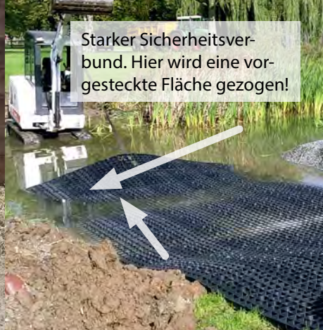
Befestigung einer Durchfahrt
