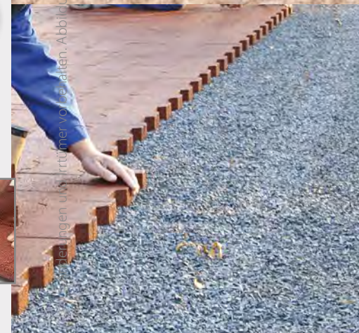
Verlegung auf Splittbett
