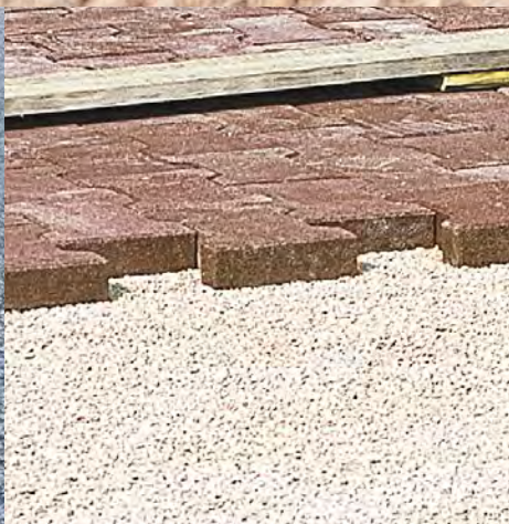
Verlegung auf Splitt
