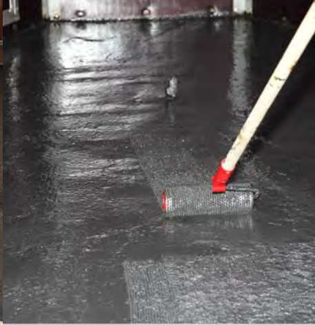
Glätten und Luftblasen entfernen
