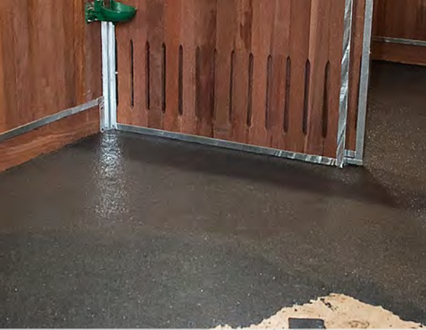
Flüssiggummi auf Betonboden
