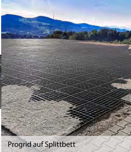
Fertig verlegte ProGrid
