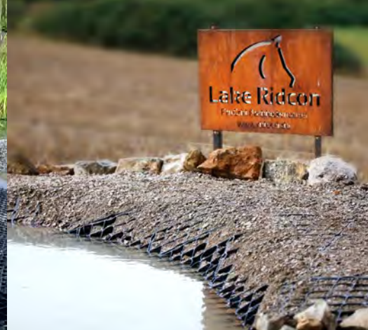
Befestigung eines Teiches
