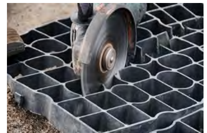
Die Progrid können Sie sehr exakt und einfach mit einer Stichsäge, Handkreissäge oder einer Flex mit Trennscheibe zuschneiden.
