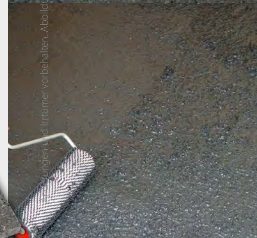
Enlüften mit der Nadelrolle
