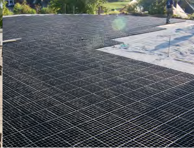
Großer Auslauf im Kreis verlegt
