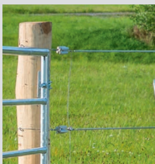
Eckpfosten mit Zugisolatoren und HippoWire
