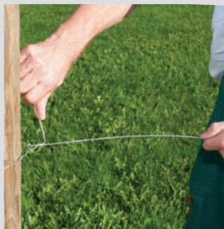
2. Loses Drahtende 3-mal um den Zugdraht wickeln
