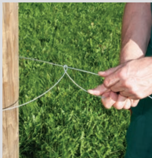
1. Draht um den Pfahl legen und eine Schlaufe bilden
