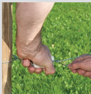
7. Loses Drahtende 5-mal um den Zaundraht wickeln
