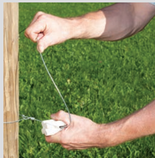
3. Loses Drahtende durch den Zugisolator hindurchführen
