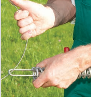
1. Draht in einen Bügel der Feder einführen
