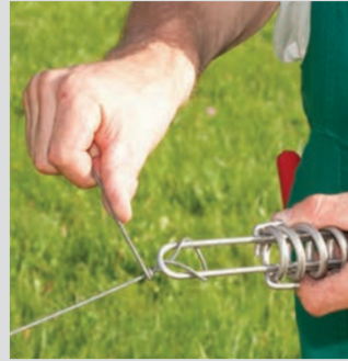
3. Die überstehenden Drahtenden um den Zaundraht wickeln
