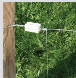
8. Drahtende lang lassen zur Querverbindung
