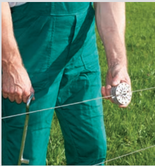
1. Spanner in den Draht einlegen, Spannugel einsetzen
